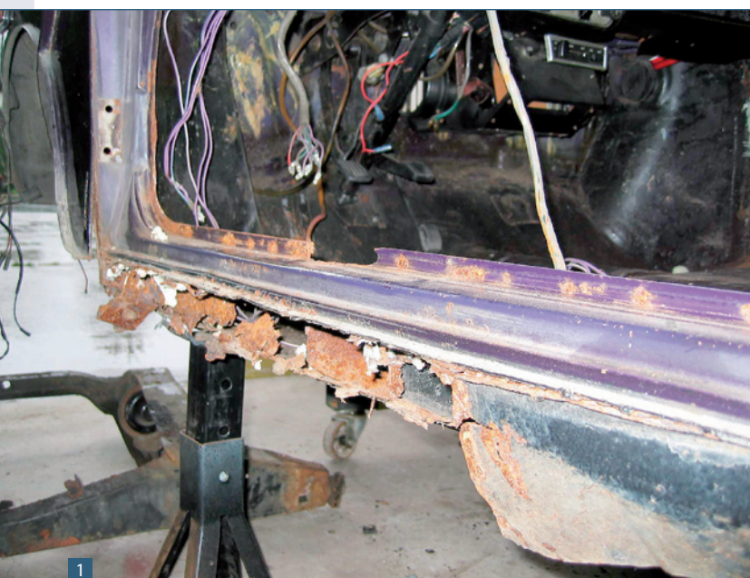
1 De dwarsbalk van het dashboard was met niets meer verbonden. Bij een ongeval zou de auto zijn samengevouwen als een natte krant.
